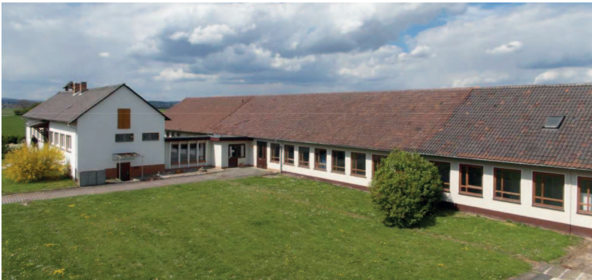
Ehemalige Ausbildungsstätten im nördlichen Bereich (von links ehemalige Schneiderei, ehemalige Schreinerei, ehemalige Wäscherei/Klempnerei)
