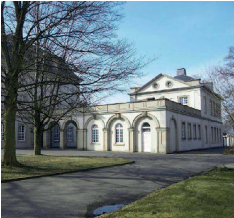
Nord-Ost-Ansicht mit Blick vom Park auf den Nordflügel und die Galerie
