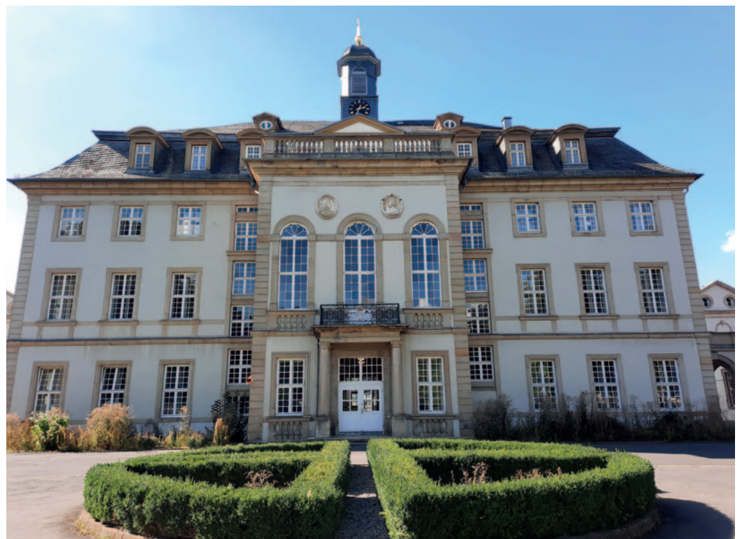
Ost-Ansicht mit Blick vom Park auf das Hauptgebäude
