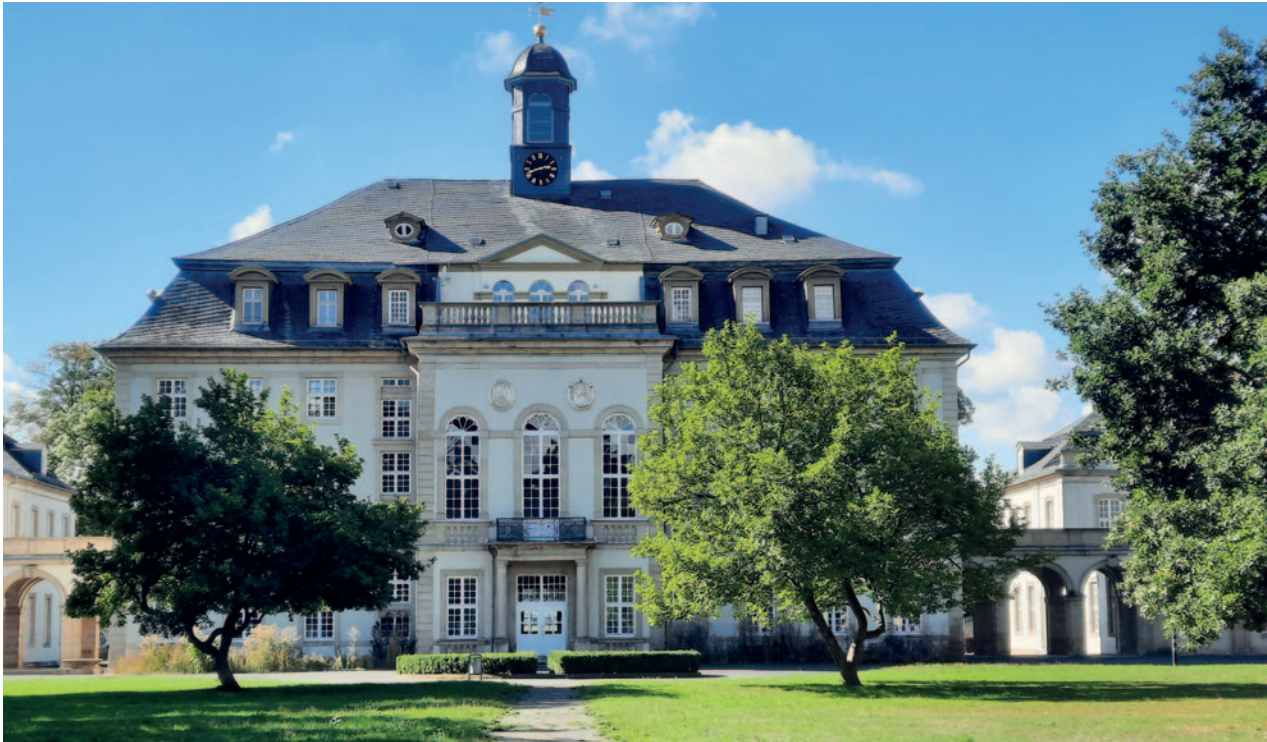
Ost-Ansicht mit Blick vom Park auf das Hauptgebäude
