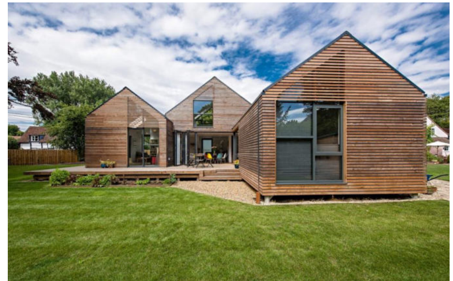
Wohngebäude in Holzbauweise (Quelle: Sunflex UK o.J.)
